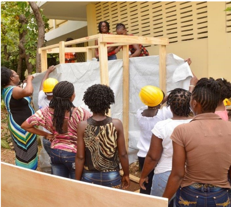
programme d'urgence - formation WASH / montage de latrine en situation d'urgence
